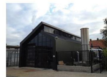
Pompruimte: warmte verdeelcentrale
