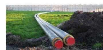
Warmte leidings (tijdens de aanleg)
